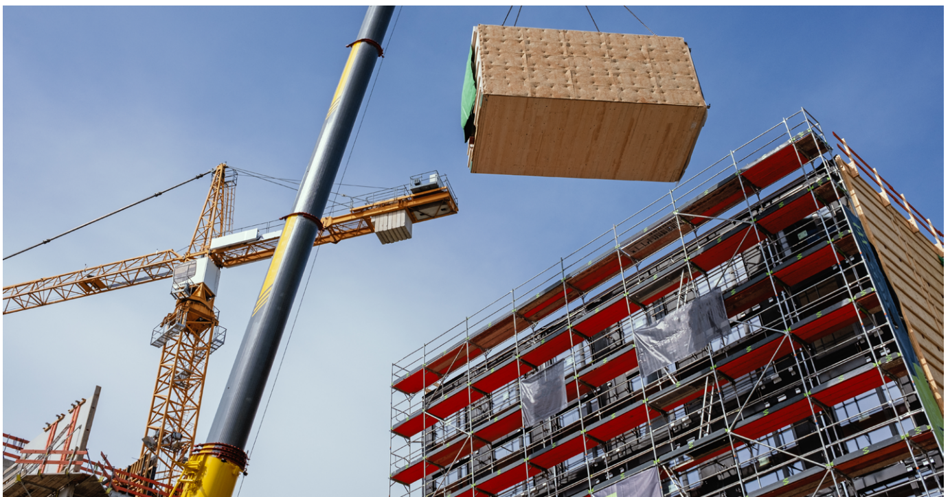
Projekt „Woodstockchen“: In Kölns größtem Neubau projekt in Holzbau weise entstehen vier Mehrfamilienhäuser mit 84 Wohnungen.
