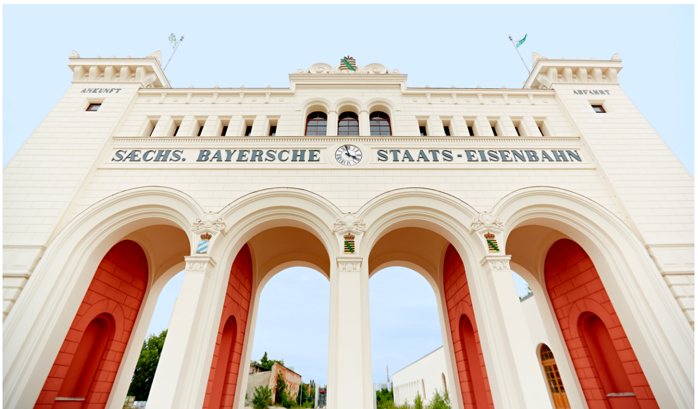
Historischer Bayerischer Bahnhof: Auf dem Gelände entstehen mehr als 150 neue Wohnungen.
