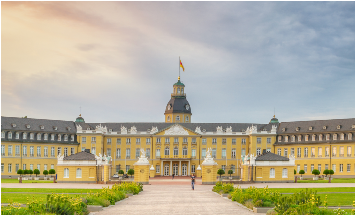
Schloss Karlsruhe: Die Nachfrage nach Wohnraum bleibt hoch. Mit zusätzlichen Stockwerken auf Bestandsgebäuden will die Stadt das Angebot erweitern.
