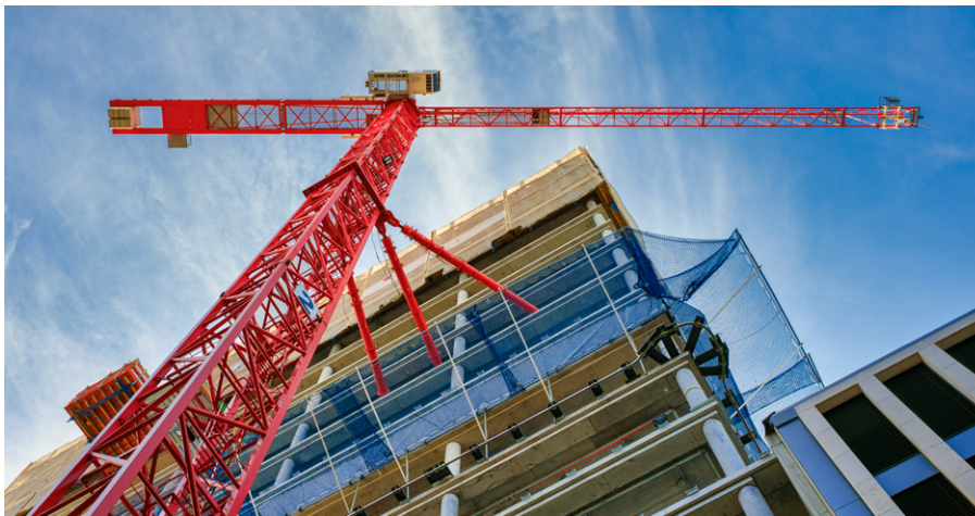
Mit modularem Wohnungsbau soll in der Hauptstadt schneller neuer Wohnraum entstehen.
